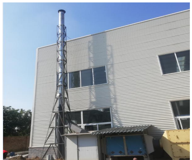
有机废气排气筒
