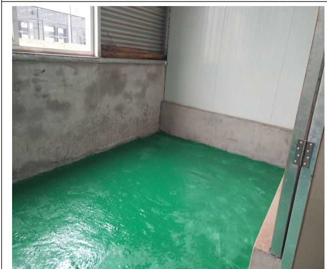
危险废物暂存间
