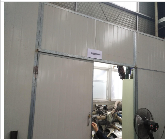
一般固废暂存间
