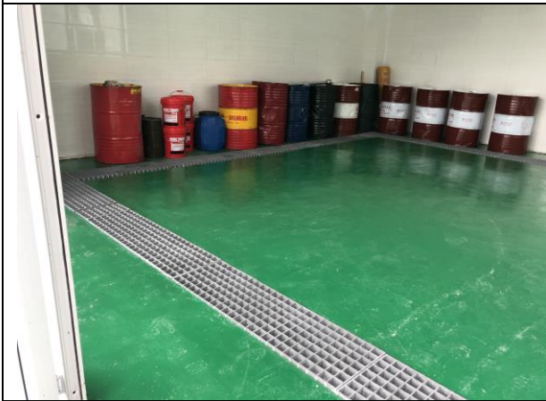
化学品库（防渗+“回”形收集沟）
