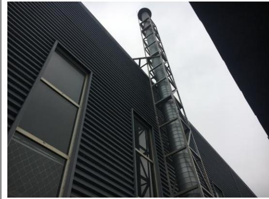
喷砂、喷涂废气处理设施排气筒
