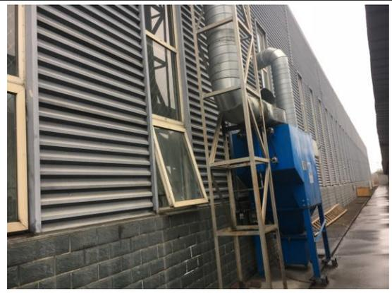
喷砂、喷涂废气处理设施
